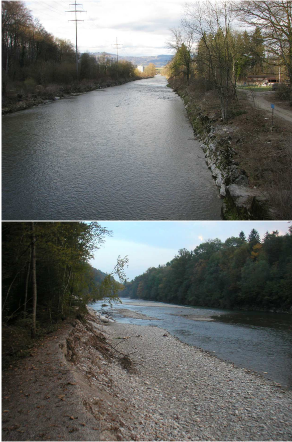
Bild 1: Bestehendes Gerinne (links) und mögliche Entwicklung nach der Gerinneaufweitung (rechts, Beispiel Emme im Winterseyschache oberhalb Burgdorf)
