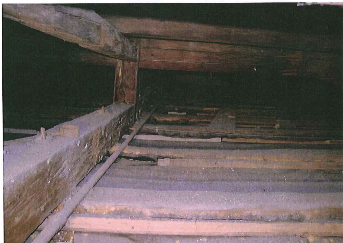
Hohlboden über Decke KR-Saal
