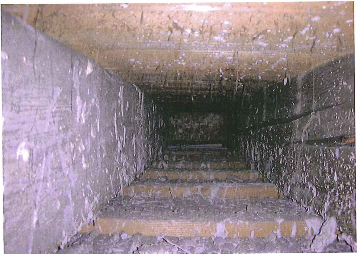
Balkenlage der Tragkonstruktion des Bodens KR-Saal
