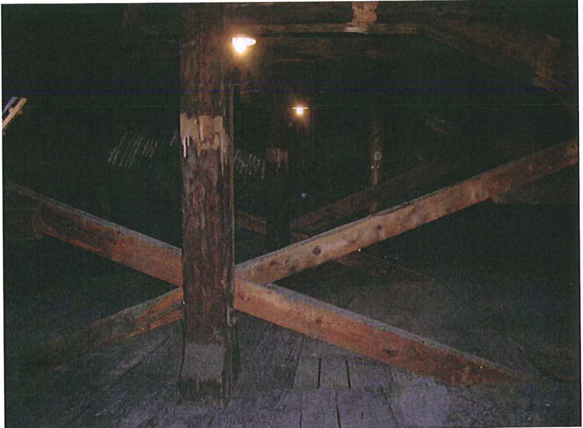
Dachbinder-Konstruktion im Estrich (Dachgeschoss)
