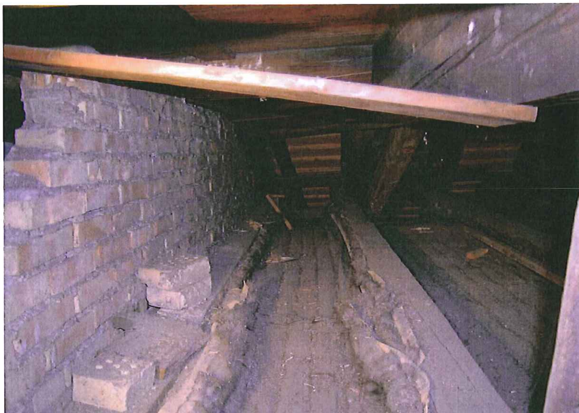
Hohlboden über der Decke KR-Saal
