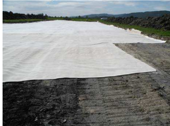
Bauphase: Verlegen der Bentonitmatten.
