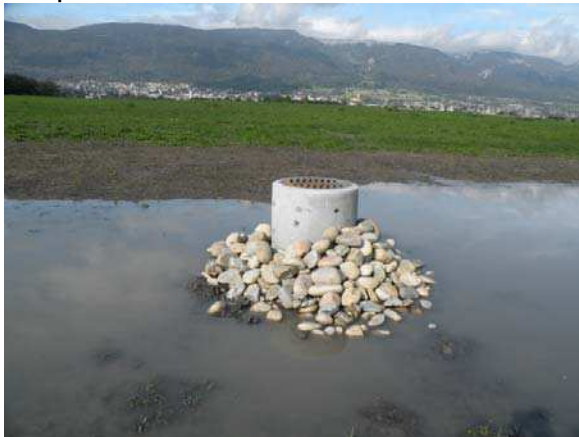
Ablaufsystem mit regulierbarem Standrohr.
