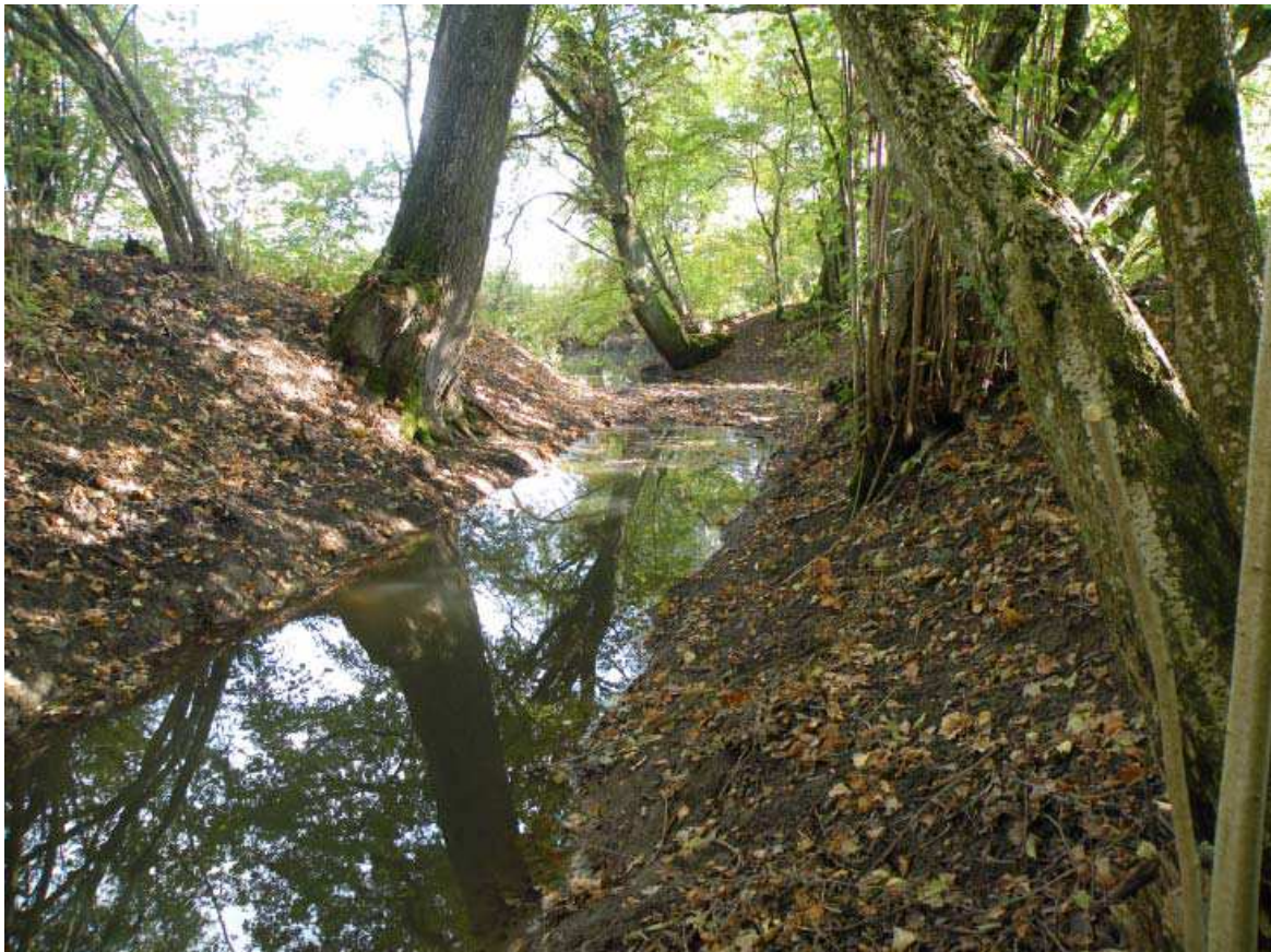
Nach Instandstellung: Der Seitenarm führt auf 200 m Länge wieder Wasser.
