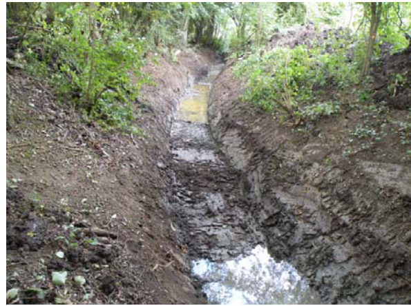
Der Graben wird geflutet.
