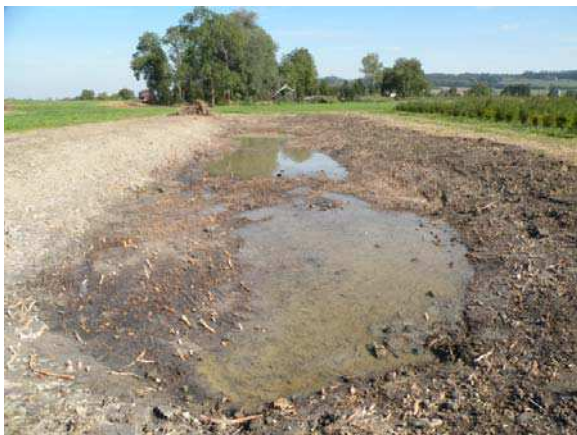
Der östliche Weiher nach der Instandstellung.
