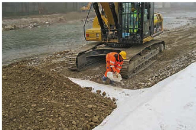
Ein neuer Damm entsteht.
