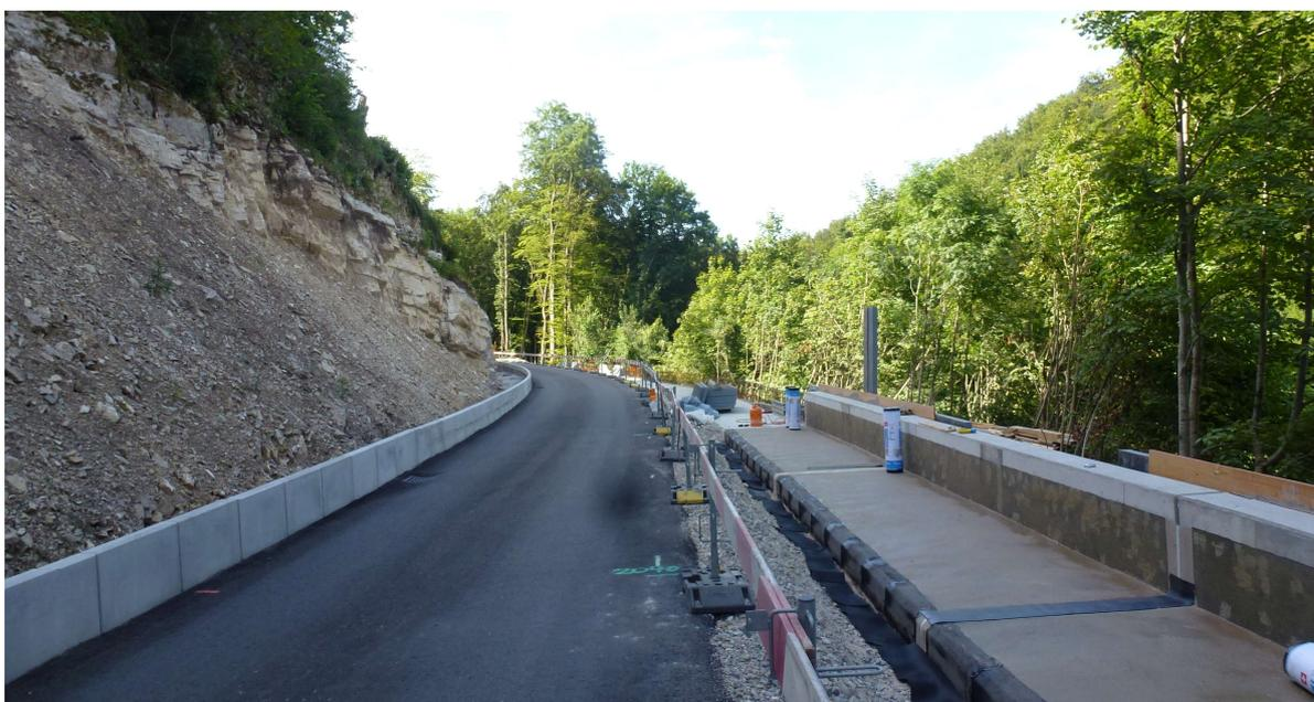
*Talseitige Stützkonstruktion auf Mikropfählen im Abschnitt der Phase 1*
