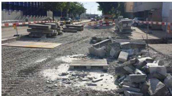
Abbildung 2: Steindepot (Zwischenlager)
