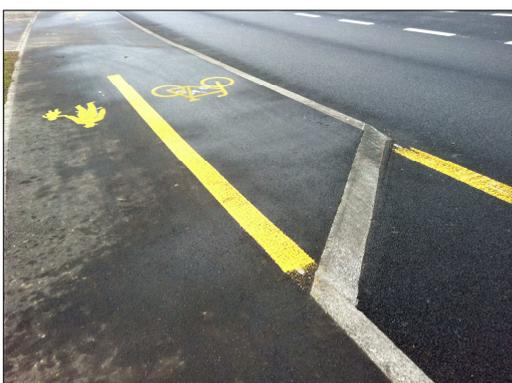
Übergang kombinierter Rad - / Gehweg auf Radstreifen mit Trennelement gemäss Norm VSS SN 640 075 (Randsteinbreite 30 cm mit schrägem Absatz mit einer Niveaudifferenz von 6 cm, 45 Grad zur Fahrtrichtung).
