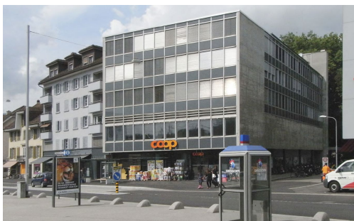
Ansicht vor der Sanierung
