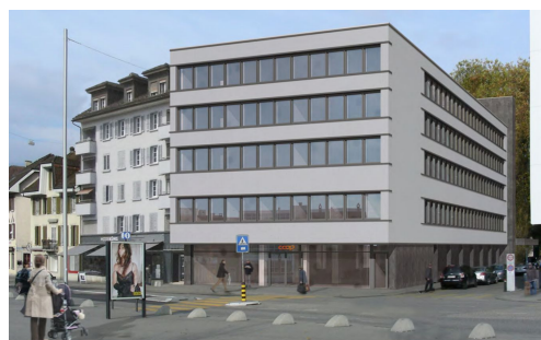
Ansicht nach der Sanierung
