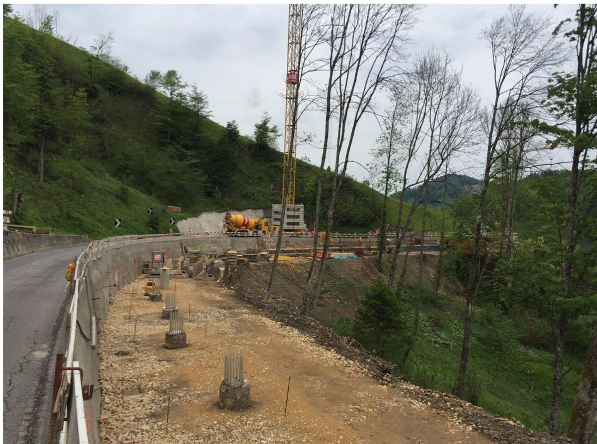
Realisiert Phase 1: Talseitige Fundation mit Grossbohrpfählen im Bereich Schiltloch
