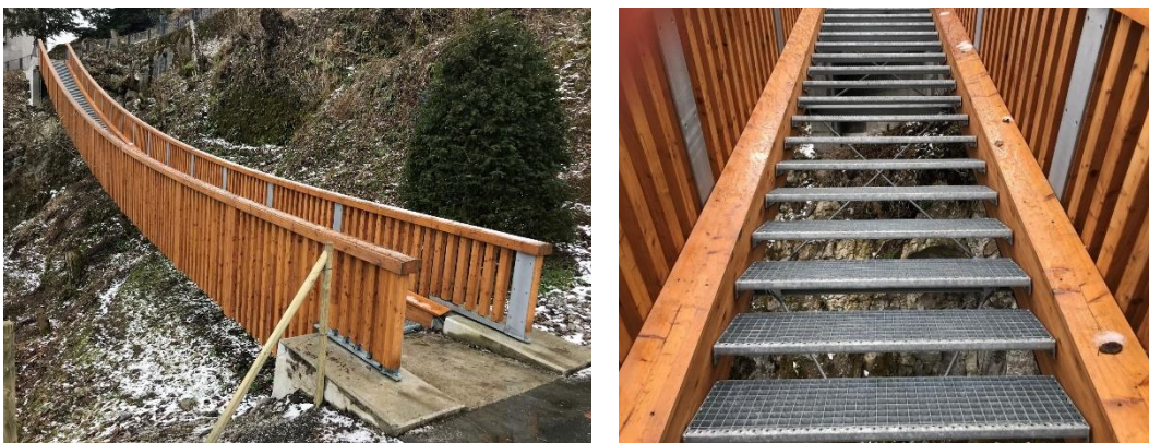
Abbildung 14: Spannbandbrücke Bürgenstock, Stansstad (Breite 0.90m)
