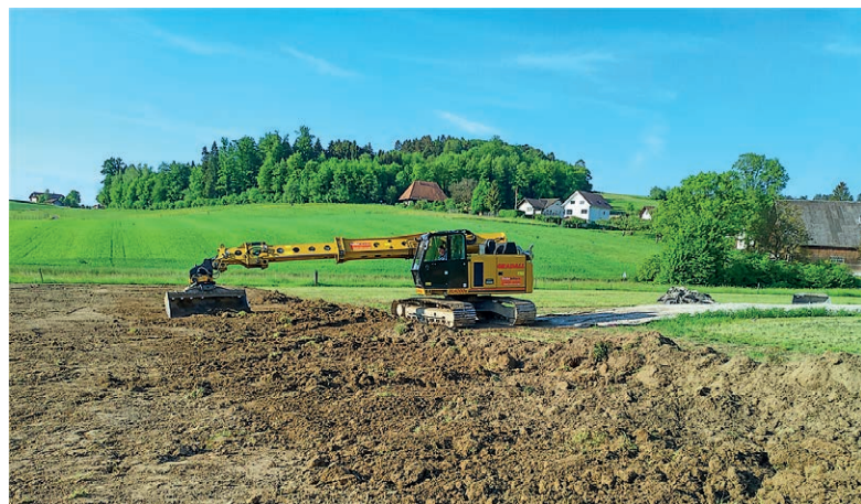
Bodenaufwertung durch Einbau von Unter- und Oberboden
