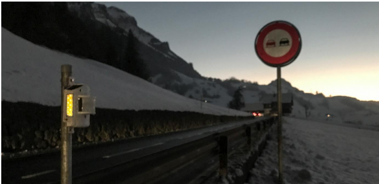
Abbildung 2: Beispiel eines Wildwarngeräts, welches den Autofahrer bei Tierpräsenz am Strassenrand mittels orange blinkendem LED-Licht auf die potenzielle Gefahr aufmerksam macht (Foto: Annette Stephani, WLS.CH).
