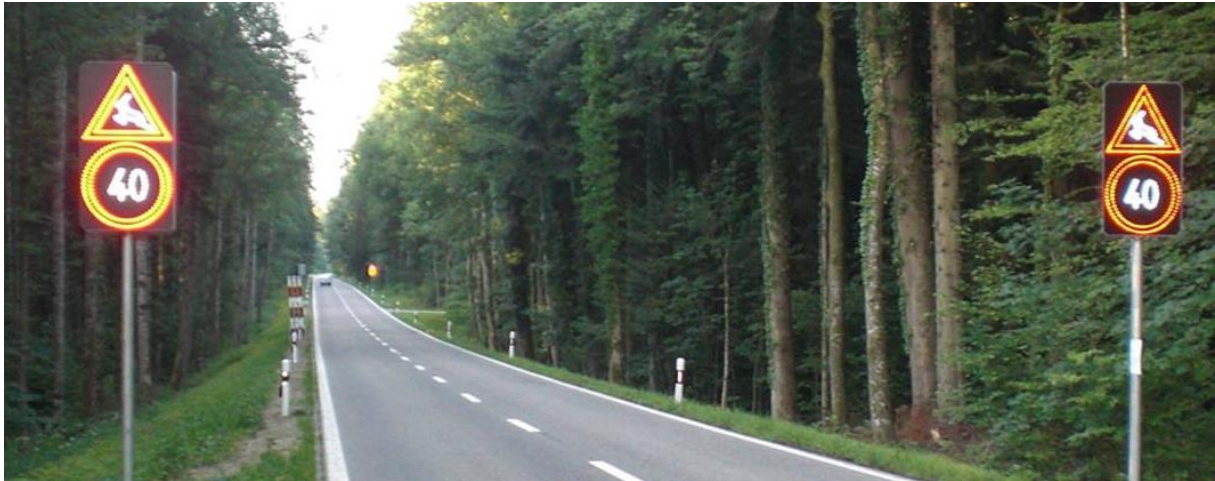
Abbildung 3: Beispiel einer Wildwarnanlage, mit eingeschalteten LED-Anzeigen, die den Fahrer auf die potenzielle Gefahr aufmerksam machen und eine Handlungsanweisung zur Temporeduktion erteilen (Foto: lokalinfo.ch, zvg).
